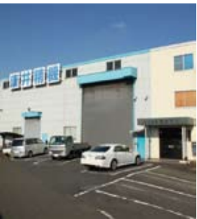
本社第一工場
